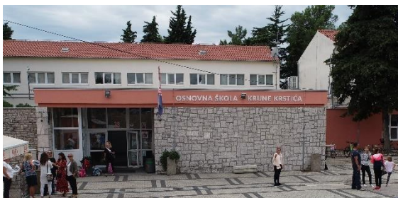
OŠ Krune Krstića (pročelje)
